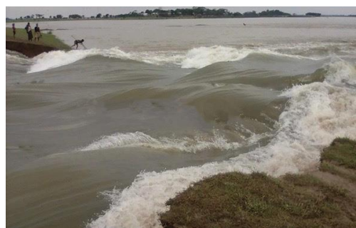
图 5.3 孟加拉国东北部塔希布尔地区被冲垮的堤防
